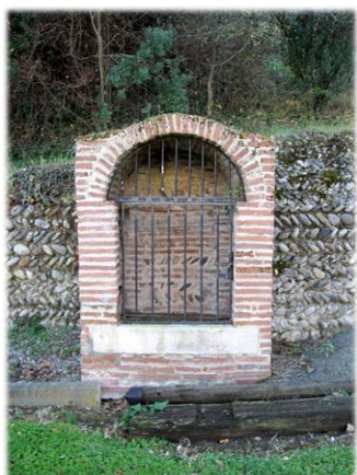
4 – Puits près de l'église
